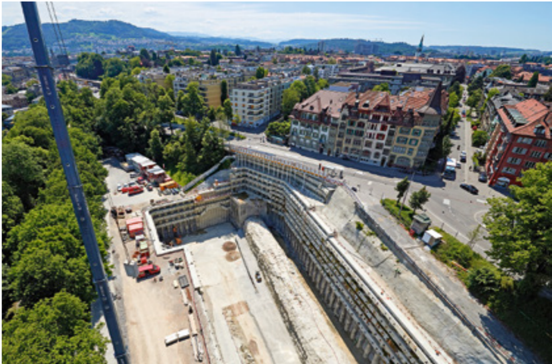
Nördlich vom Bahnhof klappt ein 160 Meter langer und 30 Meter breiter Krater. Von hier aus errichtet der Regionalverkehr RBS den Zugangstunnel zum neuen Tiefbahnhof.
