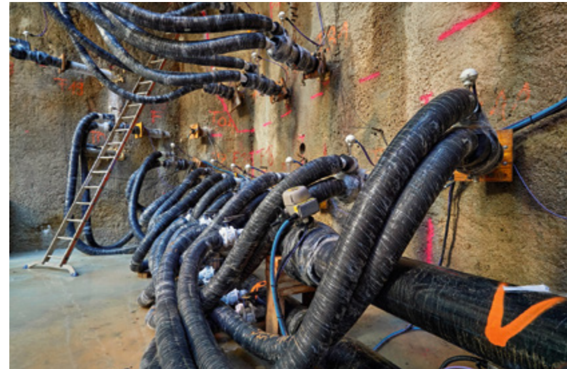
Was für Normalbürger wie ein Schlauchsalat aussieht, ist Teil des Gefriersystems, das die Stabilisierung des Bodens gewährleistet.
