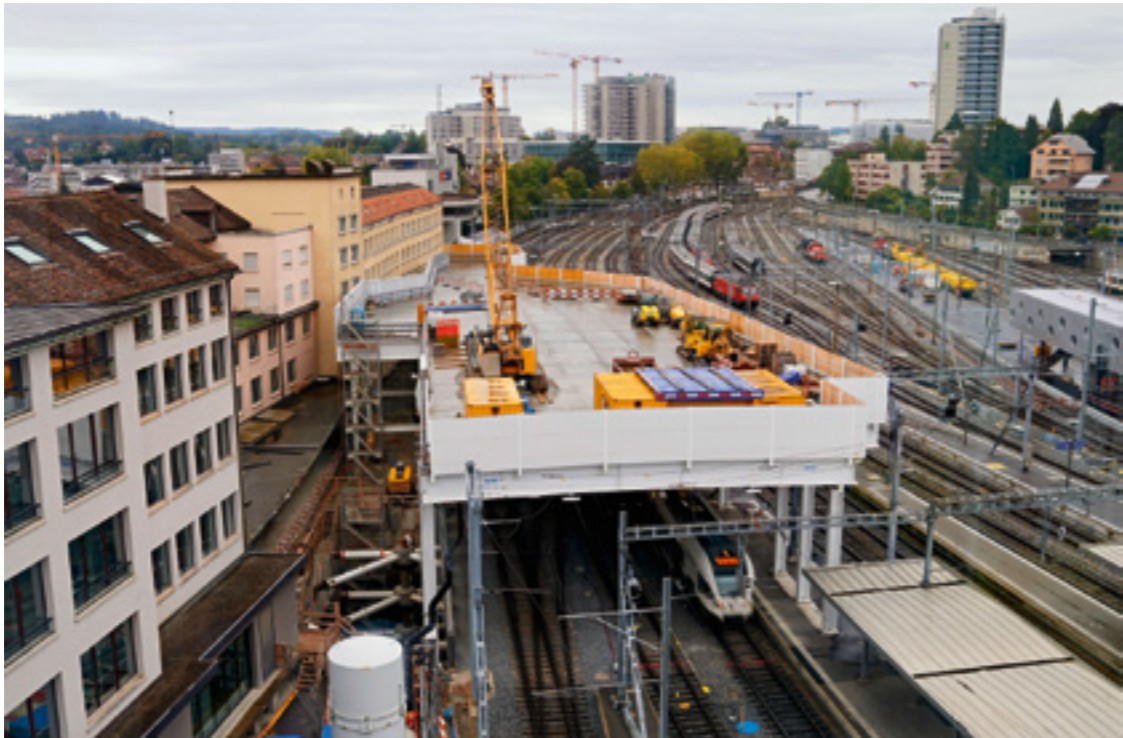
Die Stahlplattform über den Gleisen 1, 2 und 3 wurde errichtet, um den Materialnachschub zur unterirdischen Baustelle des neuen RBS-Bahnhofs zu sichern.
